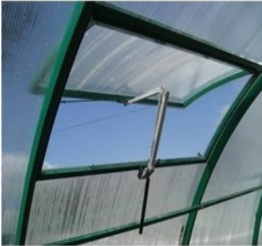
Afbeelding 5: Automatische kasroomopener met cylinder
