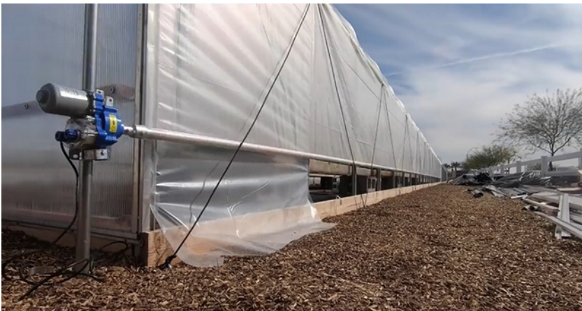
Afbeelding 61: Rolmotor voor een tunnelkas die gelijkwaardig is aan de kassen bij Moestuin de Haar
