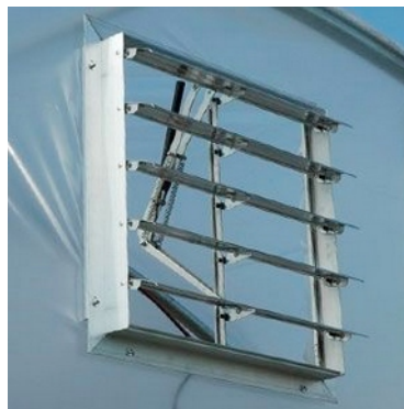
Afbeelding 40: Rooster met automatische opening mbv cylinder
