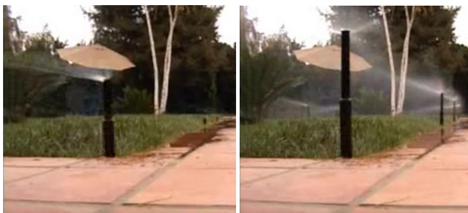
Afbeelding 68: Deze telescopische sprinklers komen omhoog als er waterdruk op komt 30,31
